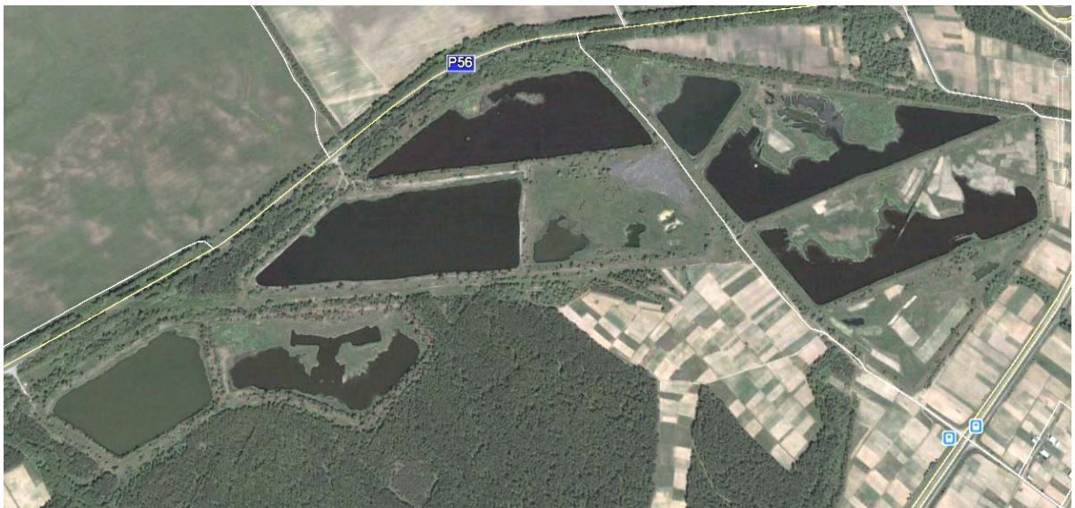
Рис. 3.4. Очисні споруди Чернігівської фабрики ПОВ
