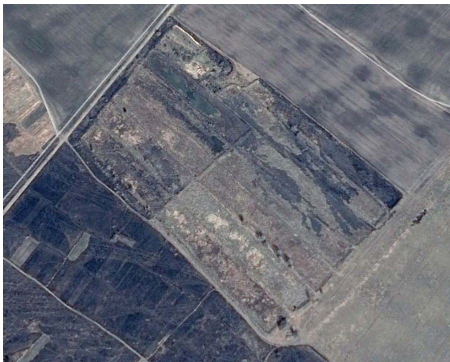
Рис. 3.5. Очисні споруди Ніжинського молокозаводу
